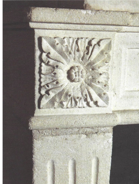
▲ Détail d'une cheminée de style Louis XVI réalisée par Philippe. Une fleur carrée sculptée à huit pétales orne le dessus du jambage. Sa double formation de tailleur et sculpteur permet à l'artisan de façonner les pierres d'un édifice et d'en sculpter les ornements.
