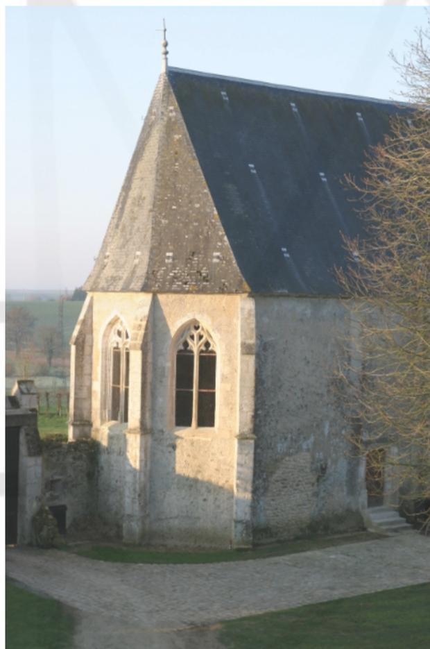
Au début du 19e siècle, la chapelle fût convertie en bâtiment agricole. Deux siècles plus tard, elle menaçait ruine. La première des deux tranches du sauvetage a été réalisée en 2008, grâce à une reprise en sous-œuvre de la charpente et un remaillage des fissures. La lumière est à nouveau rentrée dans le bâtiment, après 200 ans d'obscurité, grâce aux travaux de 2009 et 2010
